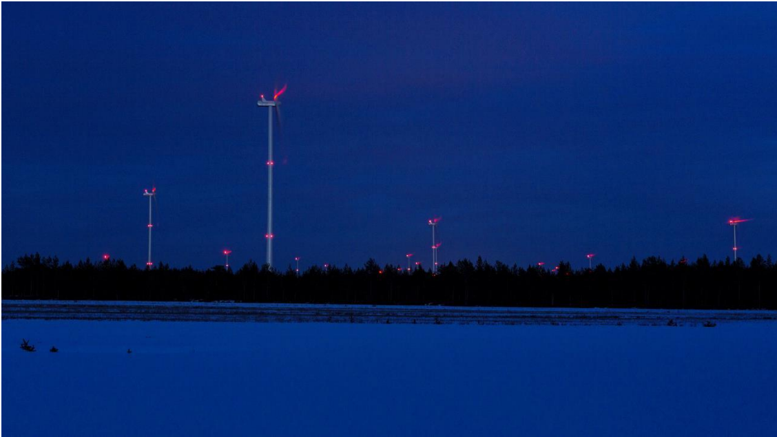
Kuva 84. Kiinteät punaiset lentoestevalot pimeällä. (Kuva: FCG)
