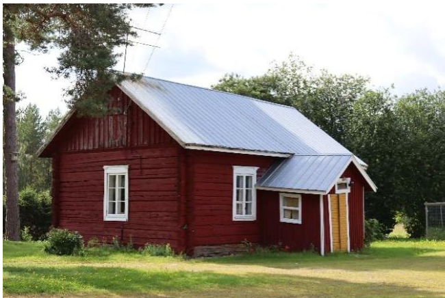
Kuva 22. Järvipellon vanha päärakennus (Kuva: FCG 2024)
