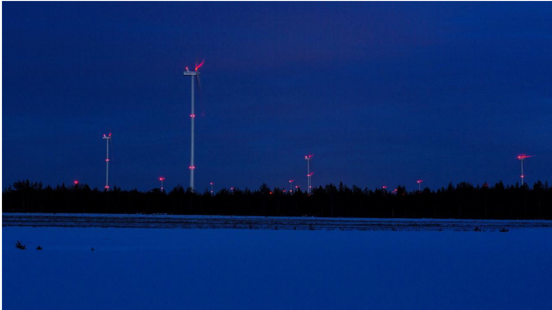
Kuva 79. Kiinteät punaiset lentoestevalot pimeällä. (Kuva: FCG)
