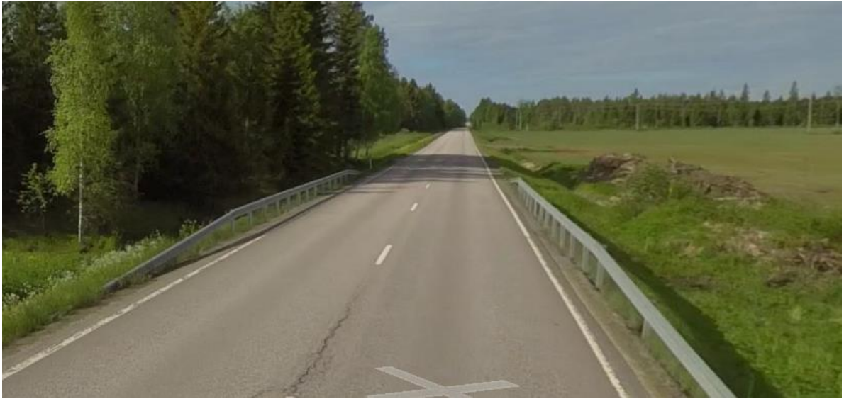
Kuva 18.9. Luonuanojan putkisilta kantatiellä 58 (Google Street View, 2022).
