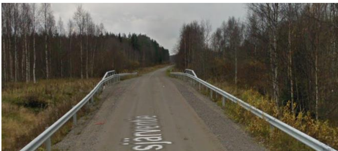
Kuva 18.7. Nevaajan silta Nurmesjärventiellä (mt7691) (Google Street View, 2022).
